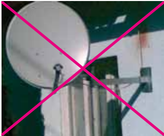
Konzoly sa nesmú nadpájať (na obrázku sú dve spojené konzoly).
